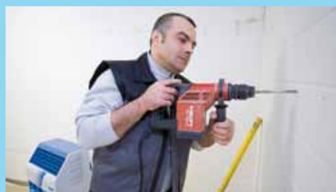
Montage- und Serviceteams
